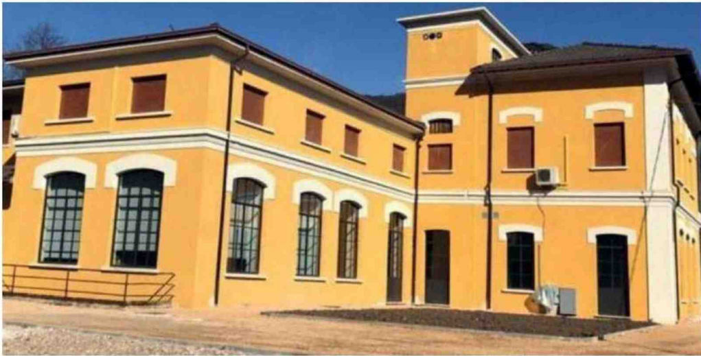
Barghe La formazione potrebbe svolgersi nell'ex centrale elettrica ristrutturata e inaugurata lo scorso anno
